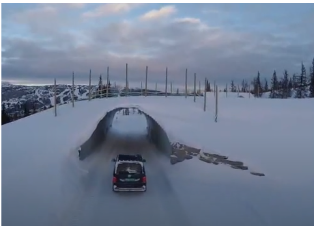
Figur 7: Alternativt kan skiløypa gå over, med trafikk tunnel under. Her fra eksempel fra Kvitfjell (av Geosynthia ( https://www.youtube.com/watch?v=ZVc59YdNOSI ))
